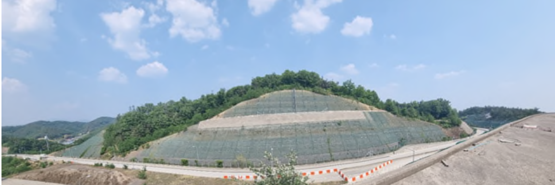
영천절토 58 (관리이정 0.920~1.340km / 8공구 화산JCT R-A 우측 STA.0+920~1+340)
