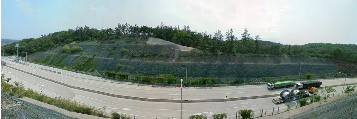
영천절토 59 (관리이정 0.860~1.120km / 8공구 화산JCT R-A 좌측 STA.0+860~1+120)
