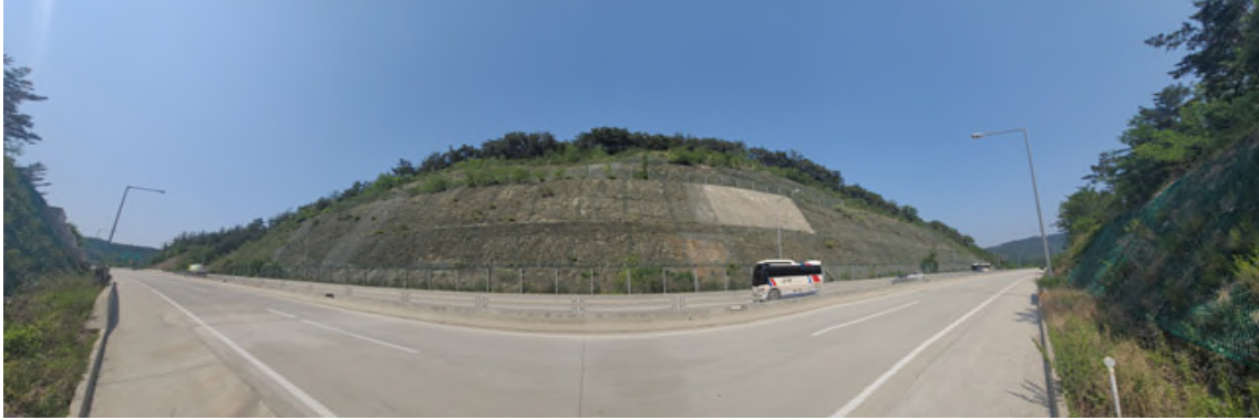
영천절토 34 (관리이정 1.890~2.150km / 5공구 군위R-A(중양)STA.1+890~2+150)
